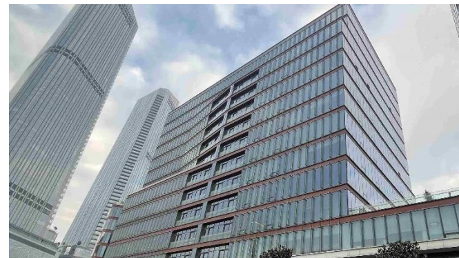
2025年2月1日開設 イスタンブール支店が入居するビル
