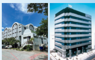
●シンガポール事務所 ●大阪新本社ビル竣工
