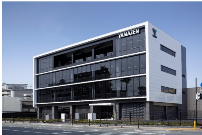
山善 九州支社 外観
