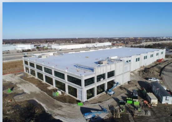
建設中の北米支社(シカゴ) 2020年8月竣工予定
