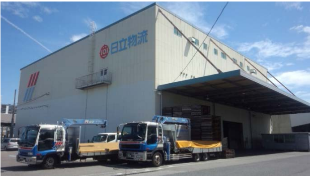
【日立物流熱田物流センター】
