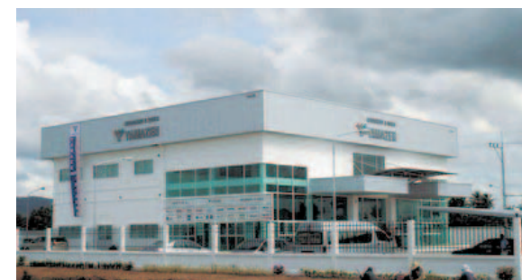
完成したピントンオフィス
